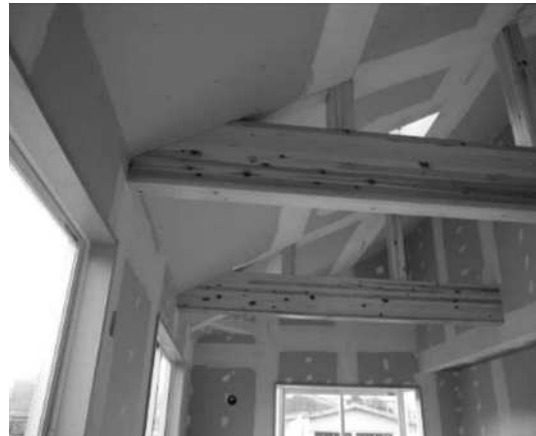
(2階LDKの天井には窓があります)
